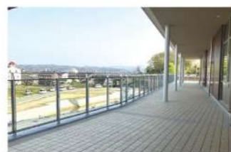
◆羽咋市内を展望できる空間と して展望デッキを整備。
